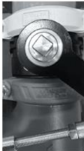
Position de la tige de vanne – Vanne de dérivation
