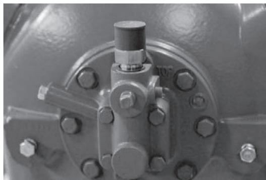
Fig. 8 – Protección de presión de aceite instalada de fábrica
