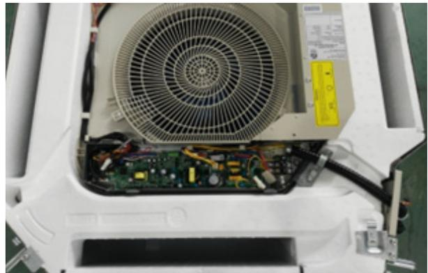
**Fig. 17 —Install Conduit Clamp**
