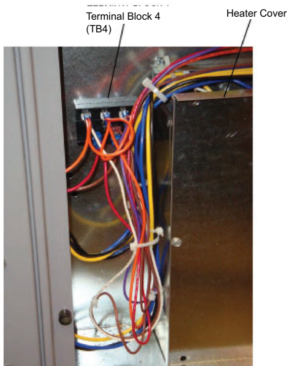
Fig. 54 — Heater Wiring
