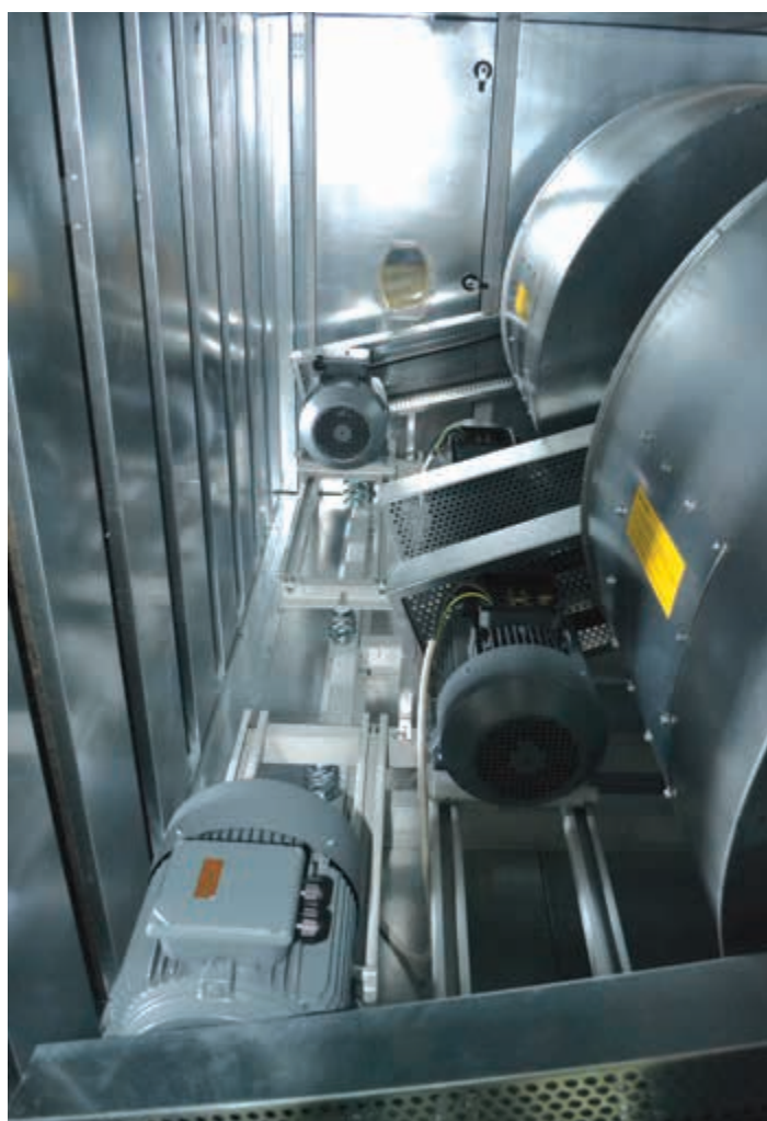
Dual fan and run & standby motor
