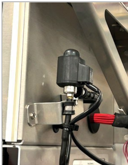
Figura 7.18 Válvula de expansión electrónica (EEV)
