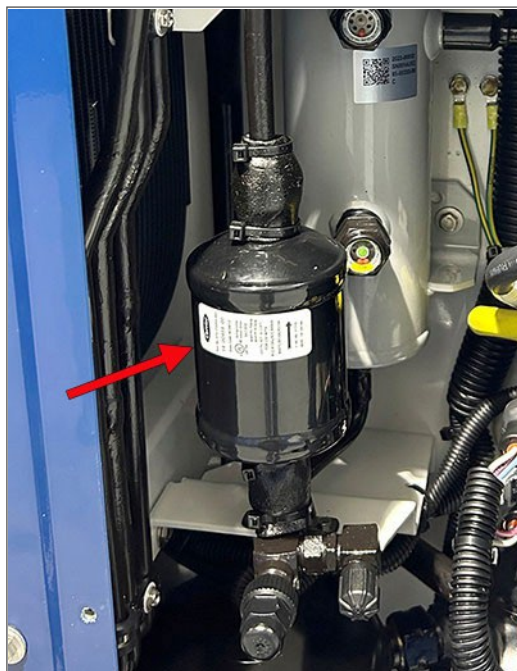
Figura 3.12 Filtro deshidratador
