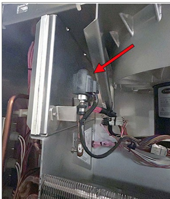
Figura 3.20 Válvula de expansión electrónica (EEV)
