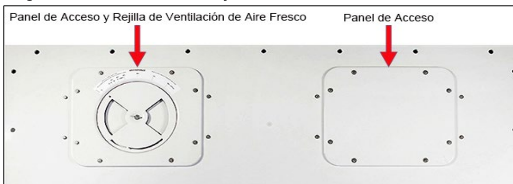
Figura 3.17 Paneles de acceso y ventilación de intercambio de aire fresco
