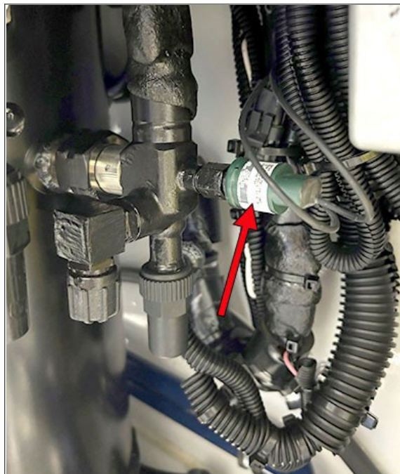
Figura 3.23 Presostato de alta (HPS)
