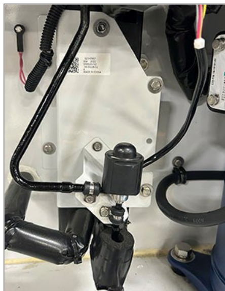
Figura 7.17 Válvula de expansión del economizador (ECV)
