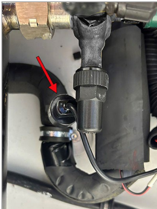
Figura 3.25 Transductor de presión del economizador (ECP)
