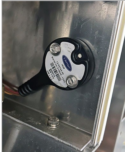
Figura 3.35 Sensor de humedad (HS)
