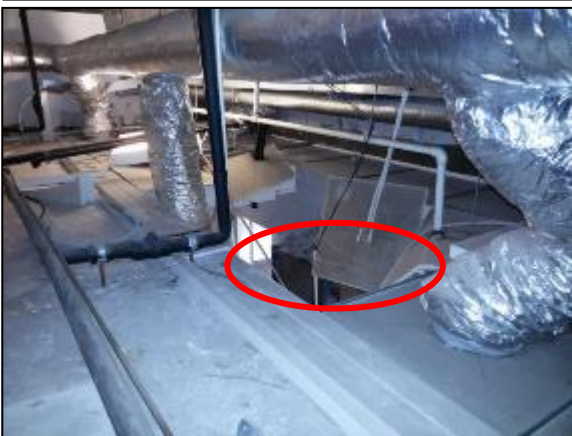
Příklady nenosných ploch; strop chladičího boxu – odlišení nenosné části stropu nebylo dostatečné
