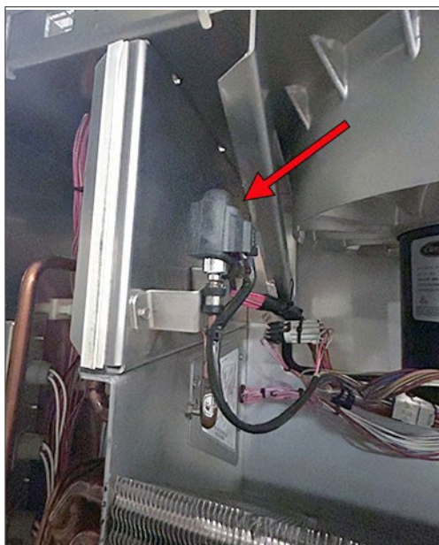
Figura 3.20 Válvula de expansão eletrônica (EEV)
