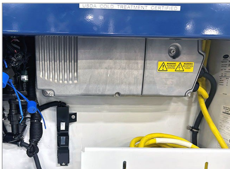
Figura 7.10 Unidade de frequência variável (VFD)
