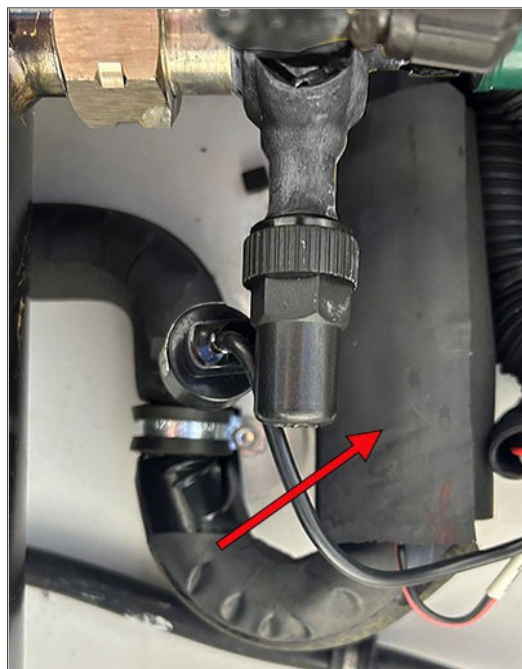
Figura 3.26 Sensor de temperatura do economizador (ECT)
