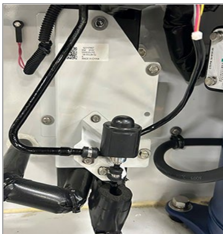
Figura 7.17 Válvula de expansão do economizador (ECV)
