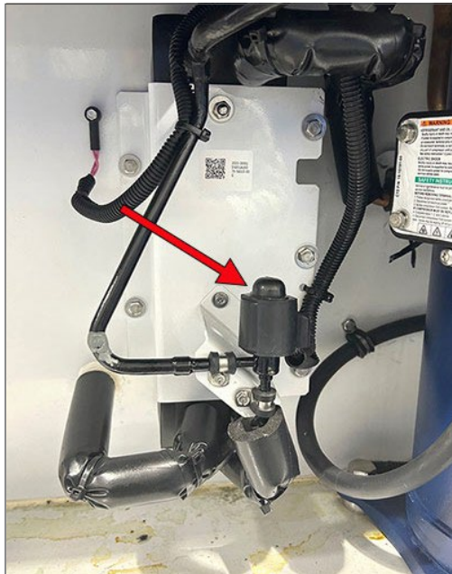
Figura 3.21 Válvula de expansão do economizador (ECV)
