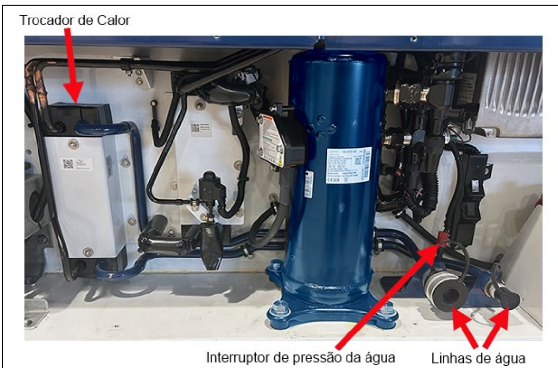
Figura 3.10 Condensador resfriado a água de placa soldada por brasagem
