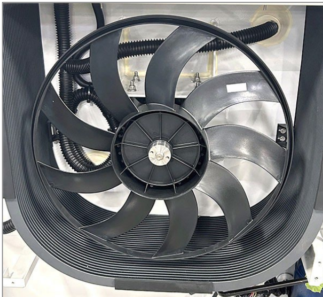
Figura 3.9 Bobina e ventilador do condensador (tampa removida)
