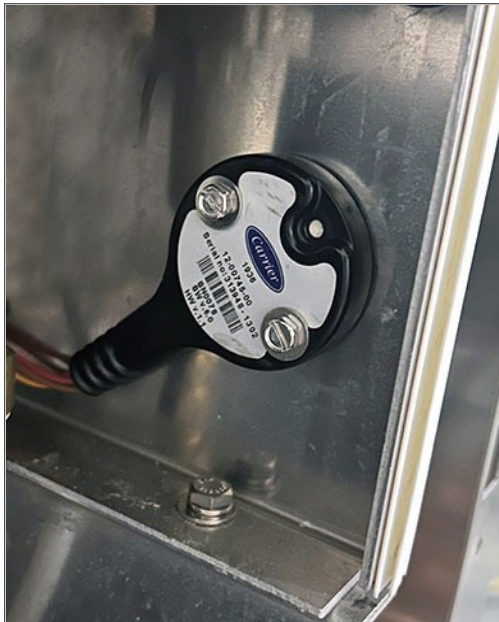
Figura 3.35 Sensor de umidade (HS)
