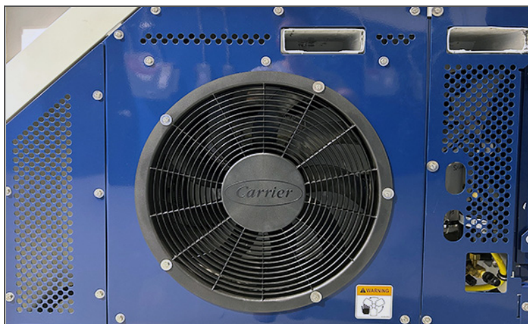
圖 3.9 冷凝器盤管和風扇
