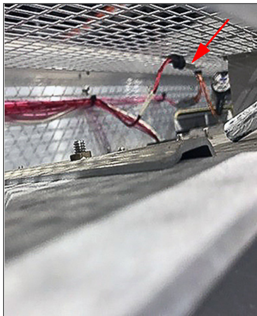
圖 3.30 回風溫度感應器 (RTS) / 回風記錄儀感應器 (RRS)
