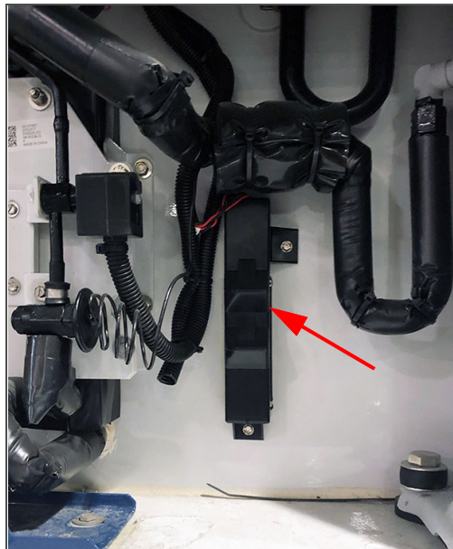
圖 3.29 送風溫度感應器 (STS)/送風記錄儀感應器 (SRS)
