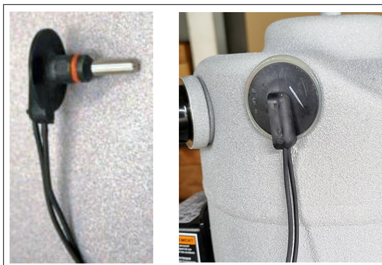
圖 7.25 壓縮機排氣溫度感應器 (CPDS)
