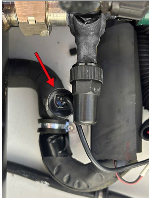
Figuur 3.25 Druktransducer economizer (ECP)
