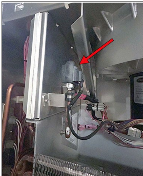
Figuur 3.20 Elektronisch expansieventiel (EEV)
