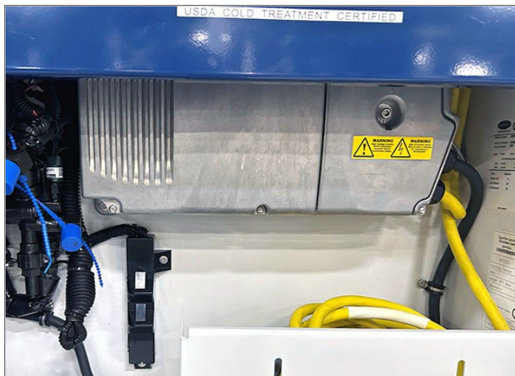
Afbeelding 3.8 Frequentieregelaar (VFD)
