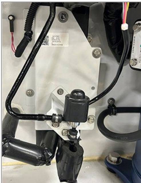
Afbeelding 7.17 Expansieventiel (ECV) van de economizer
