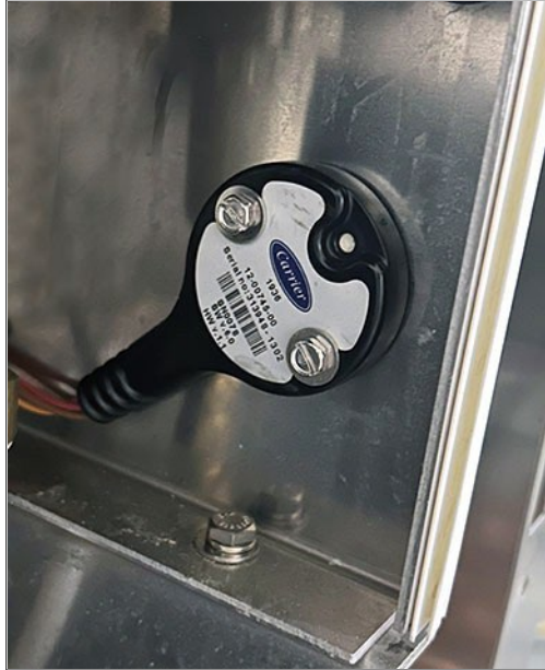
Afbeelding 3.35 Vochtigheidssensor (HS)
