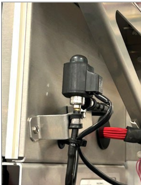
Afbeelding 7.18 Elektronisch expansieventiel (EEV)
