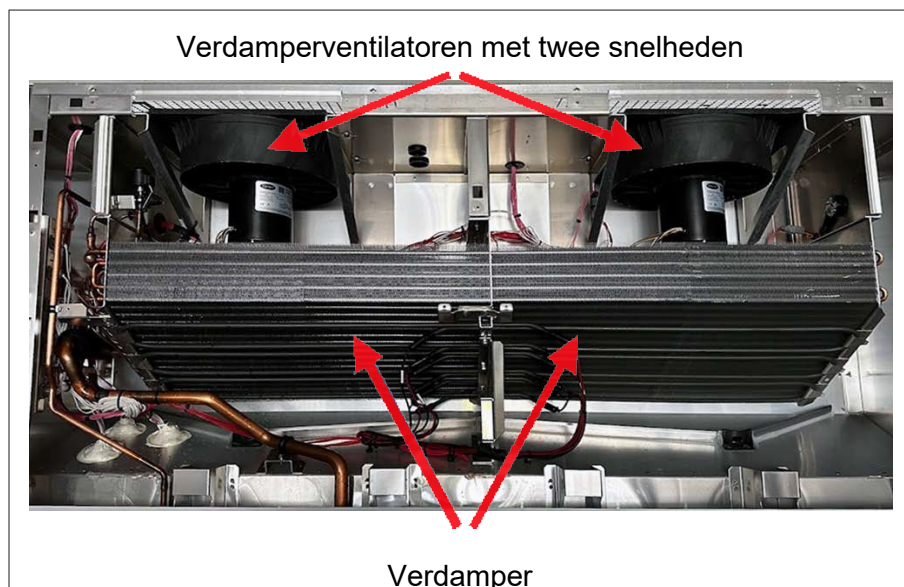
Afbeelding 3.14 Verdampers en ventilatoren
