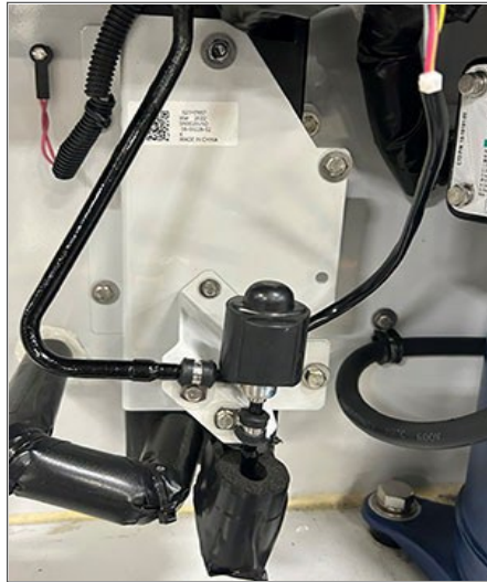
Figur 7.17 Ekspansionsventil (ECV)
