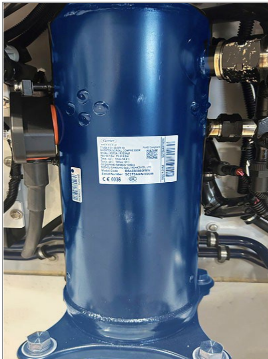
Figur 3.7 Kompressor
