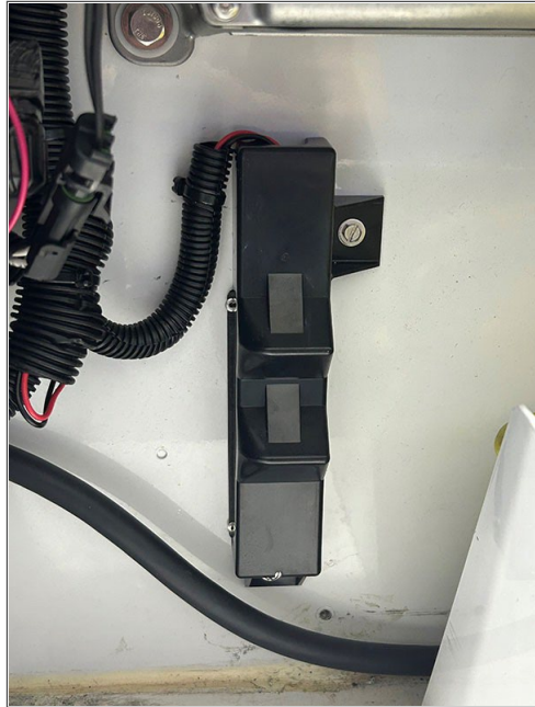
Figur 3.31 Fremløbstemperaturløler (STS) / Fremløbsoptagerføler (SRS)
