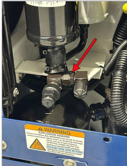
Figur 3.19 Væskeledning / King-ventil
