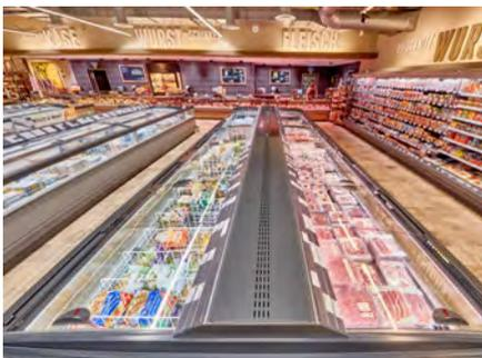
Los dos compartimentos de exposición refrigerados por separado permiten la presentación conjunta de productos de temperatura normal y baja en un solo mueble
