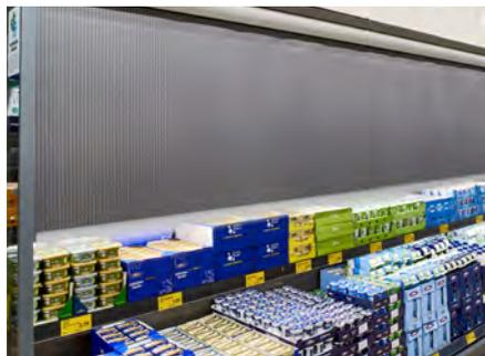
El cierre eficiente de la persiana nocturna motorizada, ahorra entre un 40 y un 70 % de energía frente al uso abierto
