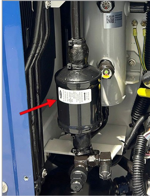
Abbildung 7.13 Filtertrockner
