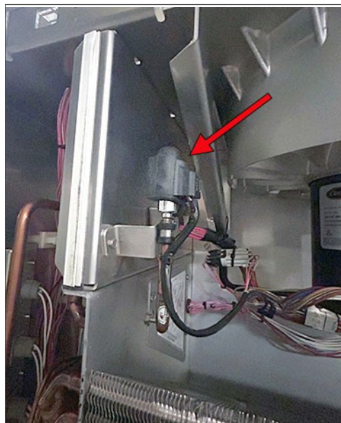
Abbildung 3.20 Elektronisches Expansionsventil (EEV)
