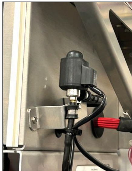
Abbildung 7.18 Elektronisches Expansionsventil (EEV)
