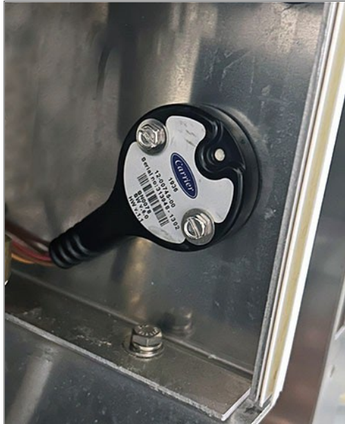
Abbildung 3.35 Feuchtigkeitssensor (HS)
