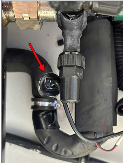
Abbildung 3.25 Economizer-Druckaufnehmer (ECP)
