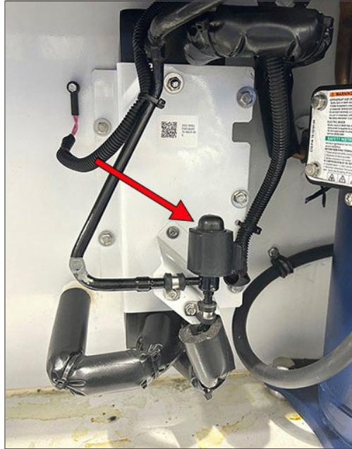
Abbildung 3.21 Economizer-Expansionsventil (ECV)
