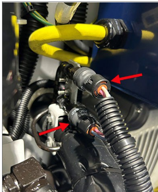
Abbildung 3.28 Verdampferdruckmessumformer - EPT (unten) und SPT (oben)
