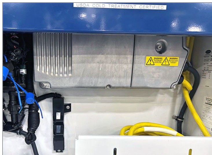
Figure 3.8 Variateur de fréquence (VFD)
