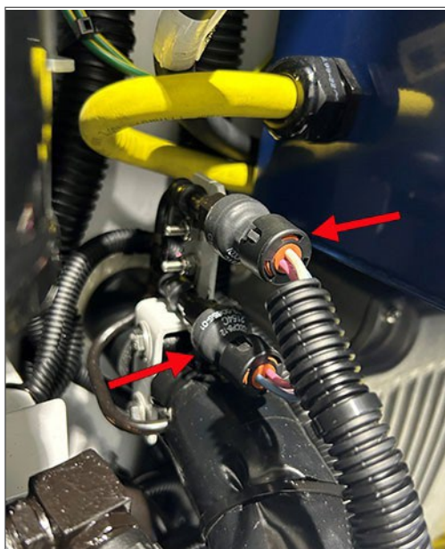
Figure 3.28 Transducteurs de pression d'évaporateur - EPT (en bas) et SPT (en haut)
