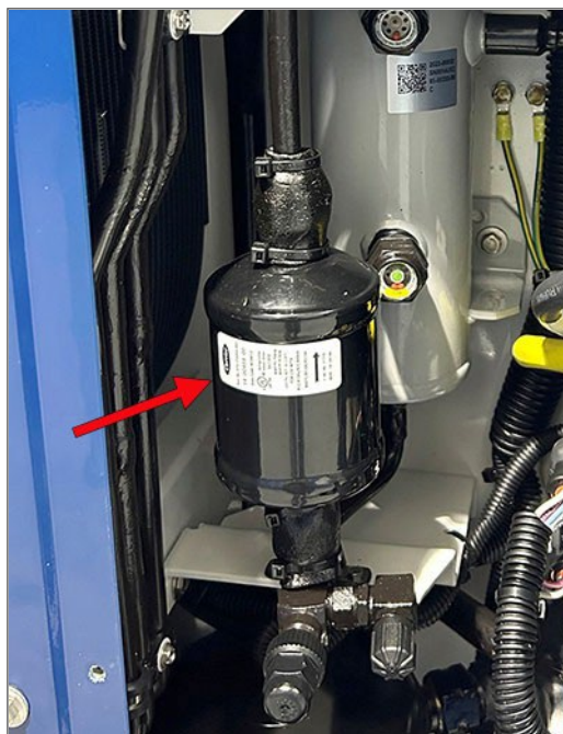
Figure 3.12 Filtre déshydrateur
