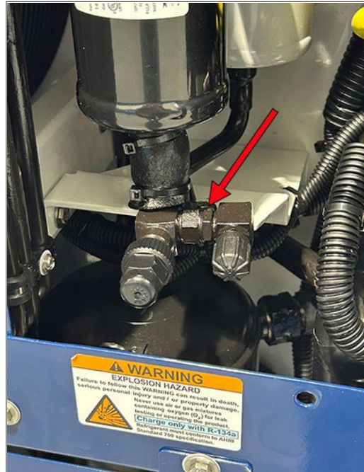
Figure 3.19 Conduite de liquide / King Valve
