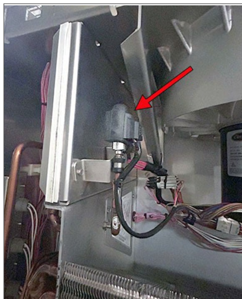
Figure 3.20 Détendeur électronique (VEE)
