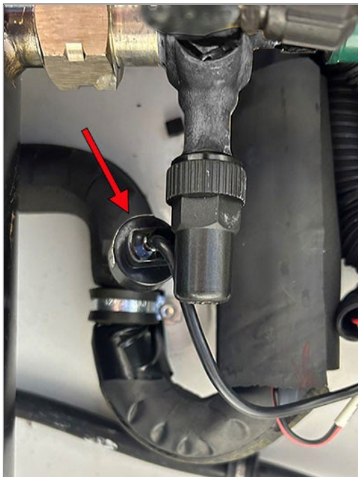
Figure 3.25 Transducteur de pression de l'économiseur (ECP)
