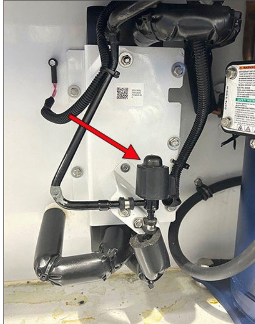
Figure 3.21 Détendeur de l'économiseur (ECV)
