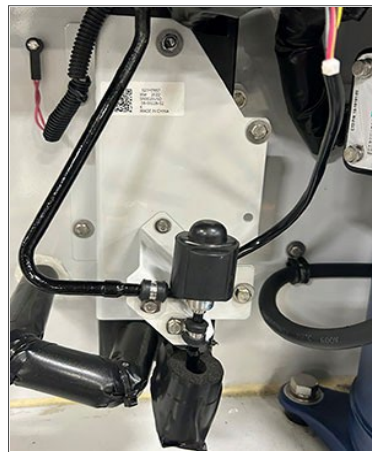
Figure 7.17 Détendeur de l'économiseur (ECV)
