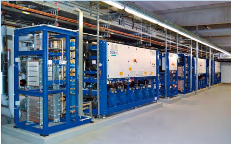
La dernière génération de centrale CO<sub>2</sub> transcritique, CO<sub>2</sub>OLtecEvo® permet une réfrigération durable et efficace au niveau énergétique, grâce à la technologie brevetée des éjecteurs et des pompes au CO<sub>2</sub>. Pour améliorer encore l'efficacité énergétique ce système révolutionnaire peut également être livré avec les options de climatisation et de pompe à chaleur.
